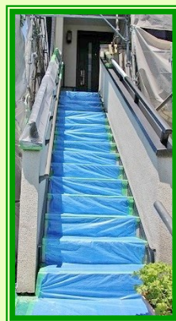
▲丁寧な階段の養生
