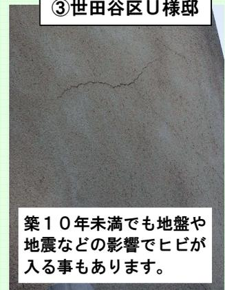
写真のように1本・2本のヒビではなく、外壁の多くの面積にヒビが入っている場合には、一時的にヒビを止めても再発の恐れがあります。
