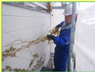
◀高圧洗浄前に外壁に絡みついたツタを撤去している宮本親方です。
