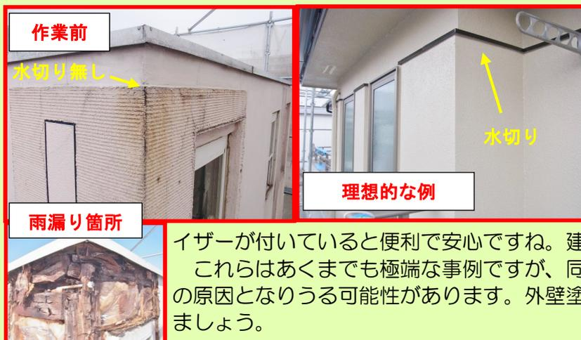
「陸屋根」と呼ばれる形状のため、建物全体を覆う屋根は有りません。この部分を解体してみると、内部の下地材どころか柱までも雨漏りによって腐朽していました。築わずか10年の建物です。柱交換などの大掛かりな工事となりました。
